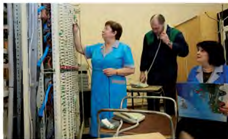
В 2018 году в состав цеха №27 входит участок связи. Его коллектив обслуживает свыше тысячи точек системы оповещения и 150 километров кабельных телефонных сетей
